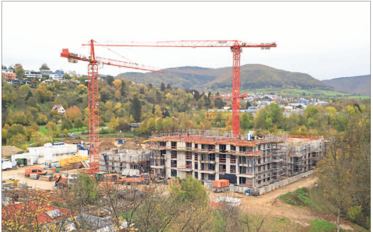
Das Arbach-Quartier nimmt Form an: Bis Anfang 2024 soll der nördliche Teil des neuen Stadtteils fertiggestellt sein, für den südlichen Teil hat der Gemeinderat mit dem Aufstellungsbeschluss des Bebauungsplans nun ebenfalls den Weg freigemacht. FOTO: REISNER
